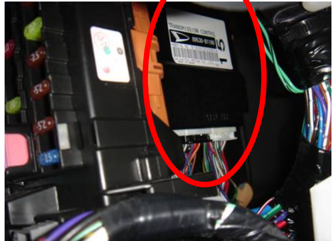
拡大写真 シールが貼ってある黒い箱です 箱の下に お目当てのコネクターが刺さっています
